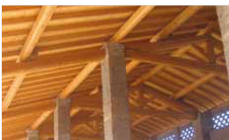
Cascina - roof trusses in „Uso Fiume“ beams
